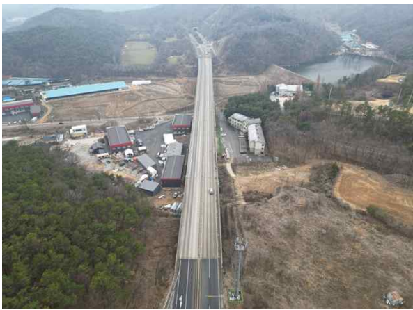
교량 상부 전경
