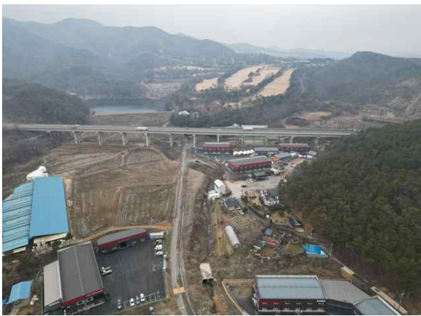
교량 측면 전경
