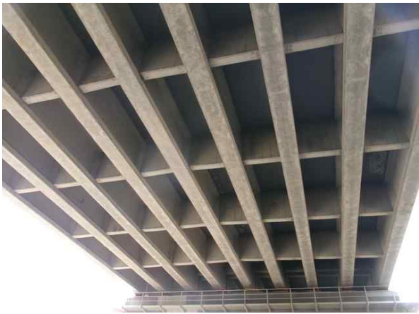
바닥판 하면 및 거더 전경
